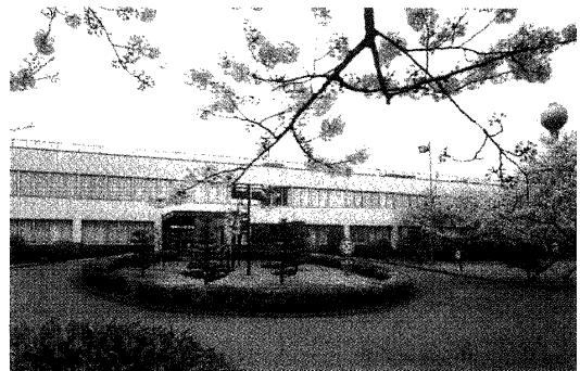
図1 研究所入口の外観
